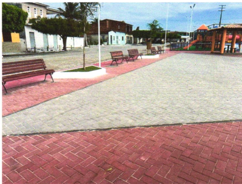
Foto 05 - Pavimentação em bloco de concreto vibroprensado, intertravado, colorido, 10x20cm, e=6cm, 46un/m 2 , NBR9781, Fck(min)=35MPa, sob coxim areia grossa compactada c/ placa vibratória, e(comp.)=6cm, rejuntado c/ areia fina.
